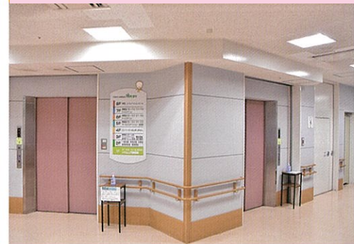
エレベーター 2 基
